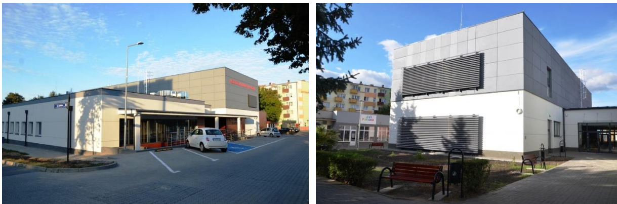
Nowa Siedziba Miejskiego Domu Kultury w Barcinie
